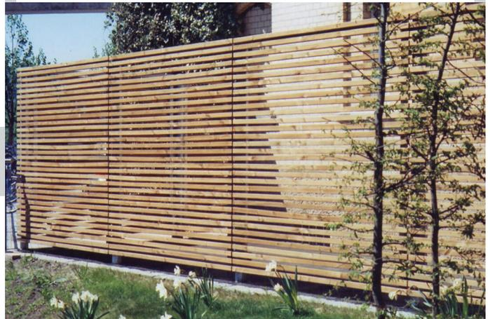
**B** Einzelne oder mehrere Elemente zur Montage zwischen Pfosten (Zusatz B), d.h. die Sichtblendenleisten schließen beidseitig mit den Pfosten ab:
