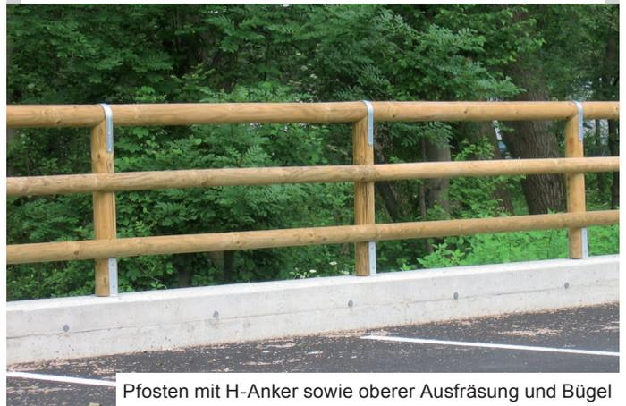
Pfosten mit H-Anker sowie oberer Ausfräsung und Bügel
