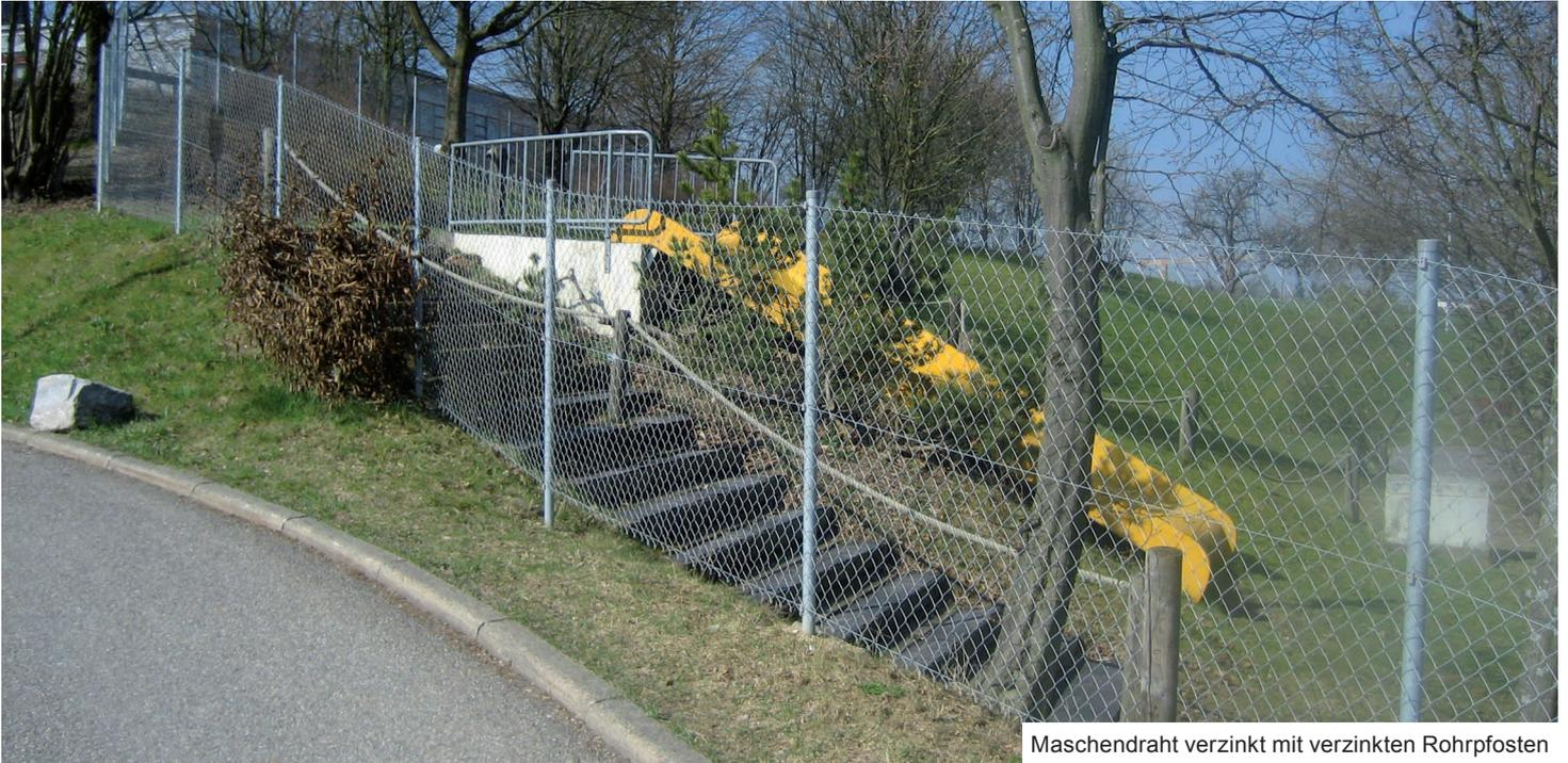
Maschendraht verzinkt mit verzinkten Rohrpfeilen
