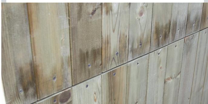
Rückseite mit passgenauen Übergängen bei den Nut-/Federbohlen
