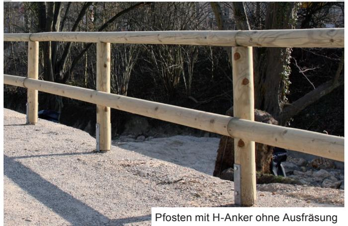
Pfosten mit H-Anker ohne Ausfräsung
