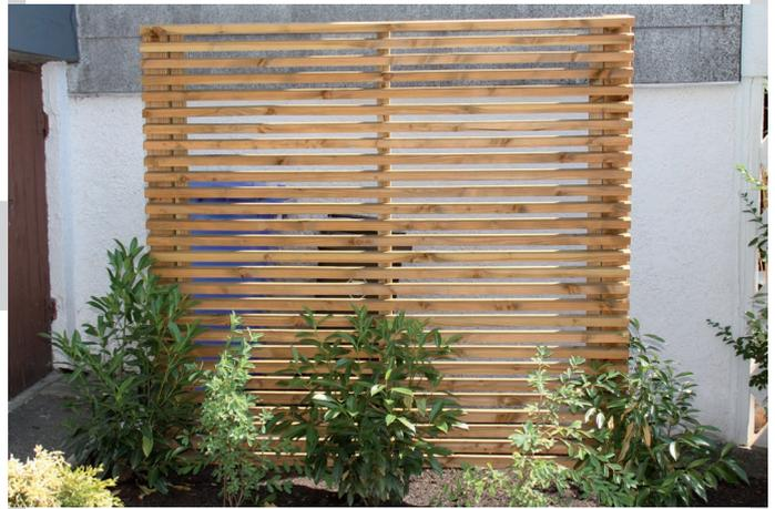
**A** Mehrere Elemente als fortlaufende Wand (Zusatz A), d.h. die Leisten werden über die Pfosten fortgeführt und verdecken diese. Es sind hierfür 3 Elementausführungen zu unterscheiden:
